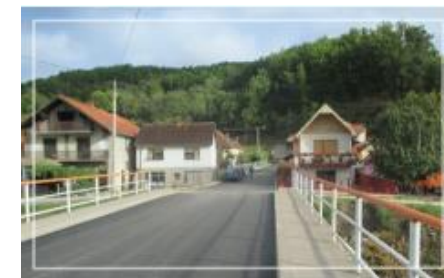
Obnova cestne infrastrukture v Krupnju v Srbiji (Slovenska karitas)
